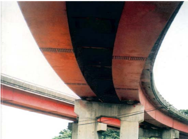
高速道路建設
