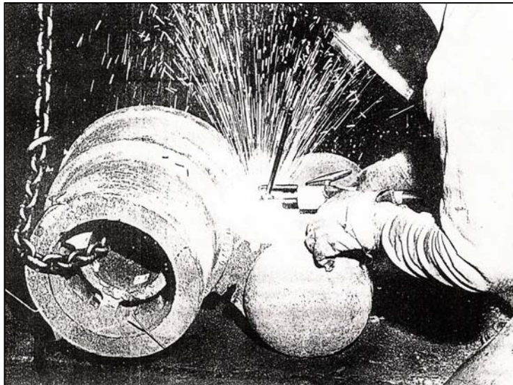
高效能開槽炭精棒鑄造物施工例
